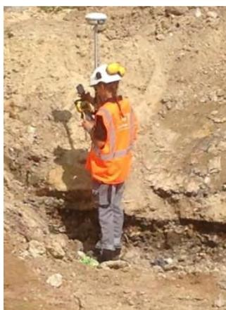
Figure 3 : Mise en œuvre du DGPS
